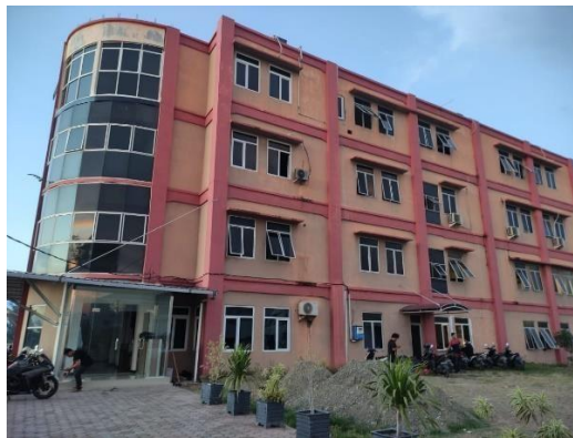
Gambar 1. Gedung asrama sulaimaniyah dari samping
